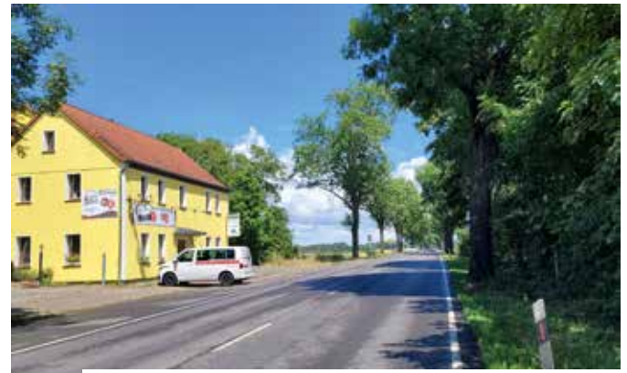
Entlang der B 87 soll ein Radweg entstehen
